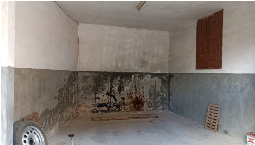
cobert B existent, destinat a garatge (interior)
