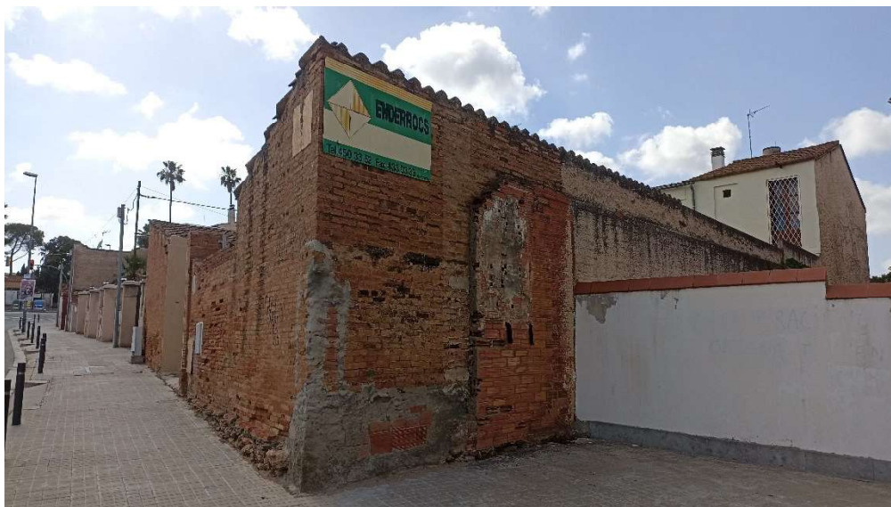
vista exterior de la zona a enderrocar
