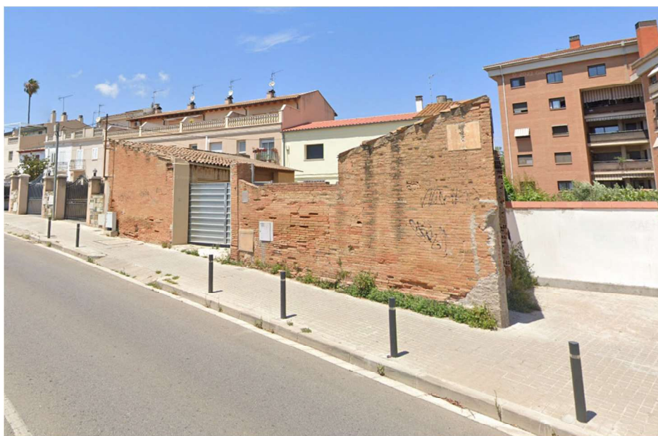
façana estat actual
